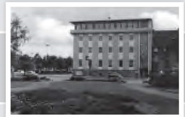
Umbau der Sparkasse zum Rathaus. Verkleidung der Fassade und Aufstockung des Hauses.
